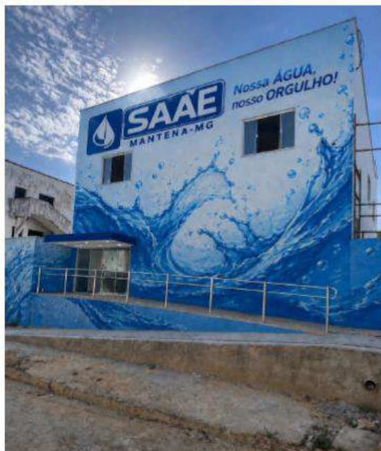
Fachada atual da sede do SAAE Mantena-MG — situação de referência para o levantamento das especificações.
